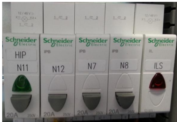
Bild 1. Knappar N11, N12 och grön indikering HIP, i elskåp.
