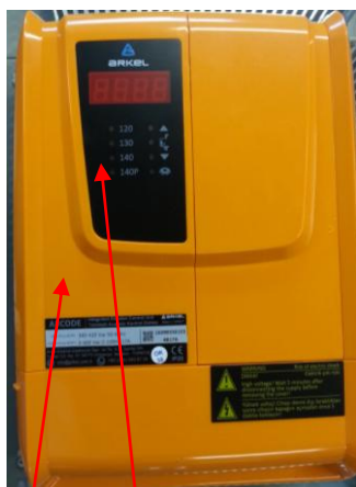
Bild 1. Arcode Hiss/frekvensstyrning i apparatskåp.
