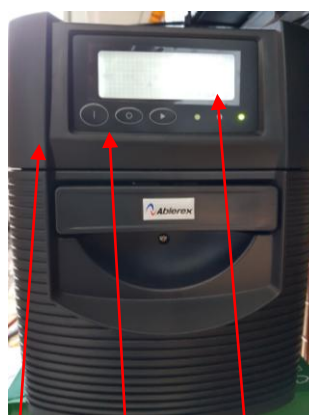
Bild 2. UPS-enhet, för Automatisk och / eller Manuell Nödmanöver. Notera att UPS-modeller och placering kan variera beroende på hisstyp.
