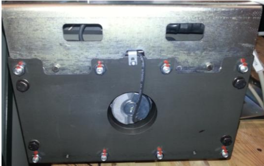
Bild 1. Pulsgivarkabel på linhissmaskin.
