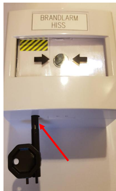
Bild 14. Återställningsnyckel i Brandtablå.
