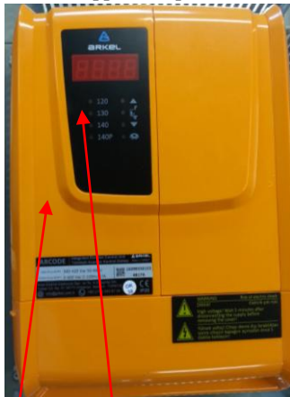
Bild 1. Arcode Hiss/frekvensstyrning i apparatskåp.
